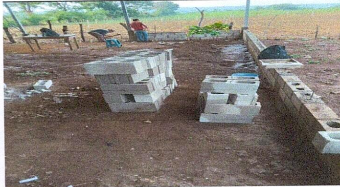
Foto 4: Avances de la construcción del muro perimetral de block.
