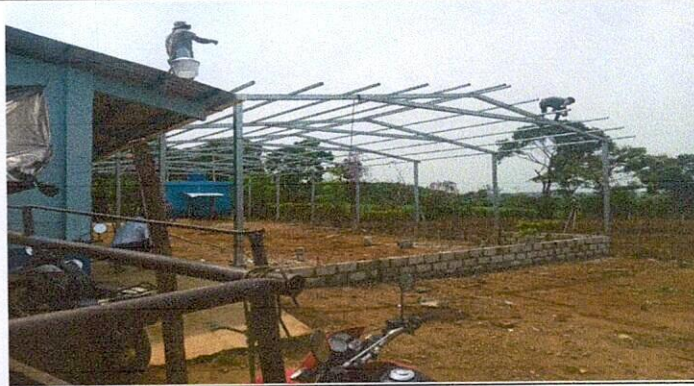
Foto 2: Construcción la estructura de soporte de metal.
