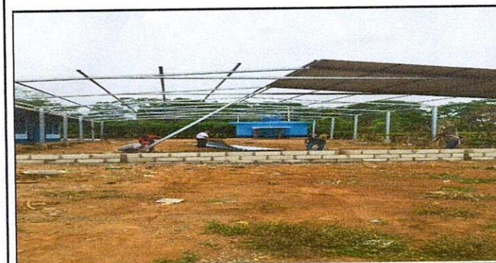
Foto 5: Inicio de colocación de lamina.
