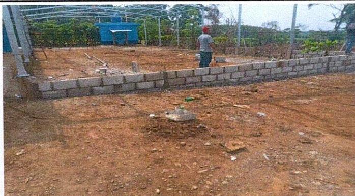
Foto 1: Reparación de muro perimetral de block en proceso.
