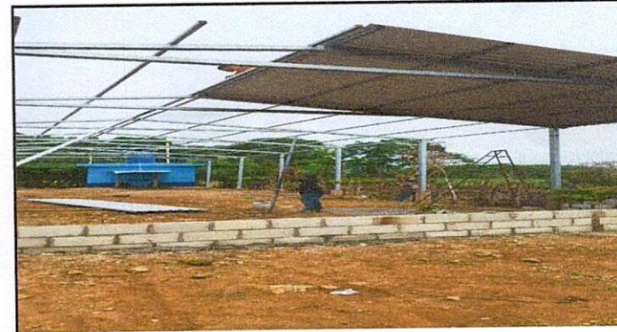
Foto 6: Colocación de lamina.
