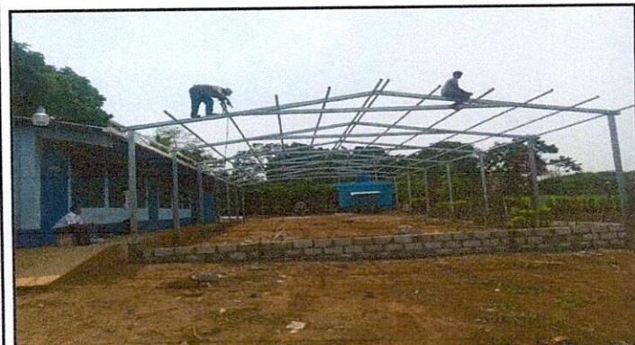
Foto 3: Proceso de finalización de la construcción del soporte de la estructura de metal.
